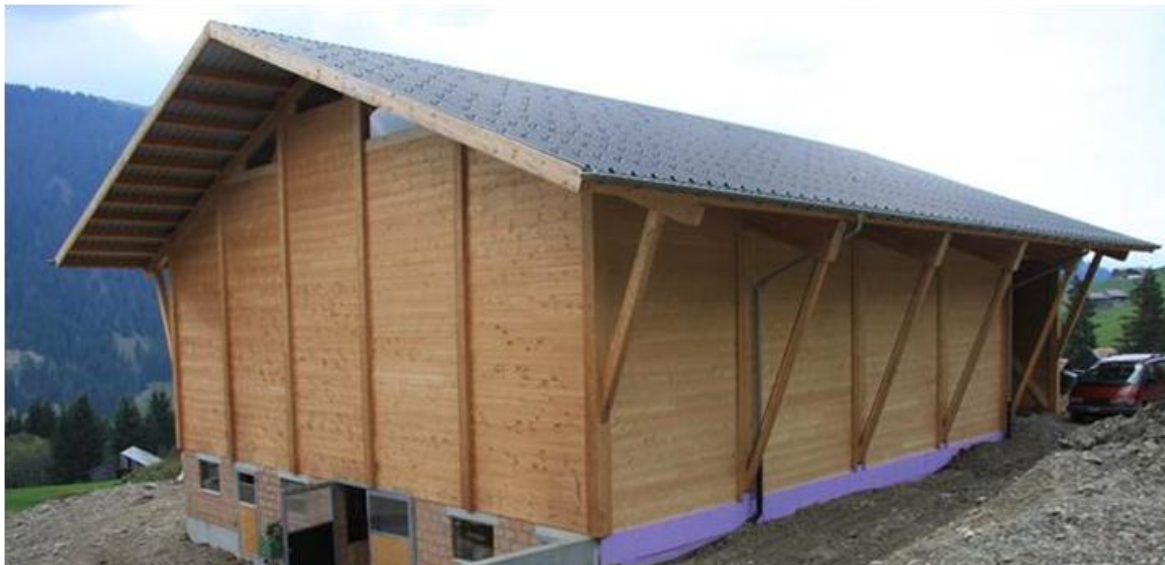
Abb. 6: Ökonomiegebäude Lauenen mit Trägern aus Buchen-BSH (Bild: neue Holzbau AG)
